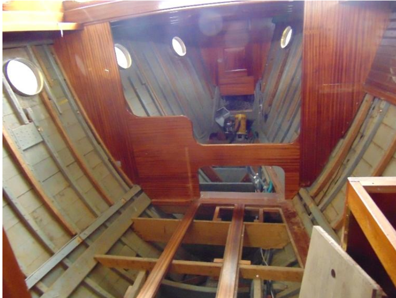
Aktueller Stand der Arbeiten (19.10.2020)
